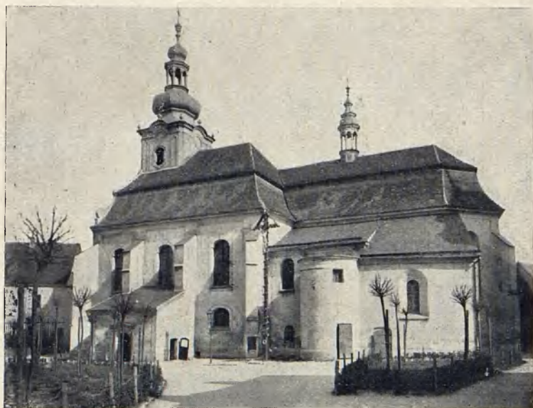
Die 1903 abgebrochene Pfarrkirche.
